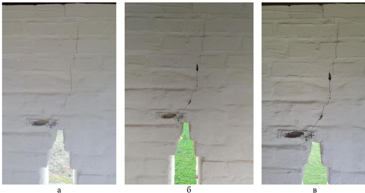
Рисунок 2. Трещина в бойнице центральной монастырской стены Печерского Вознесенского монастыря в районе трещинного маяка №11: а) в 2015 г., б) в 2019 г., в) в 2020 г.
