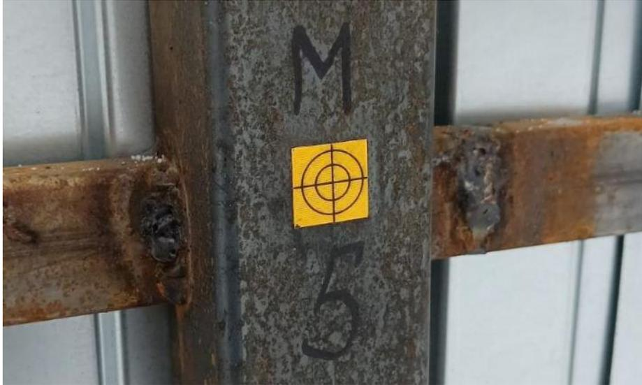
Рисунок 1. Элемент теодолитного хода с пленочным отражателем
