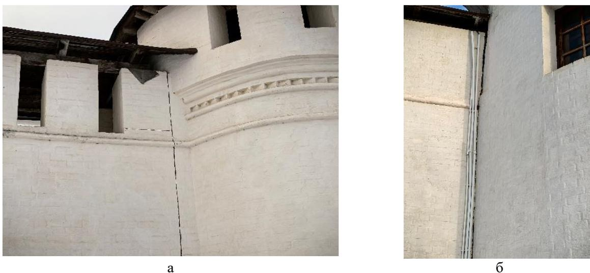
Рисунок 4. Пример температурных трещин между а) северо-западной стеной и северо-западной башней, б) между западной стеной и юго-западной башней монастыря
